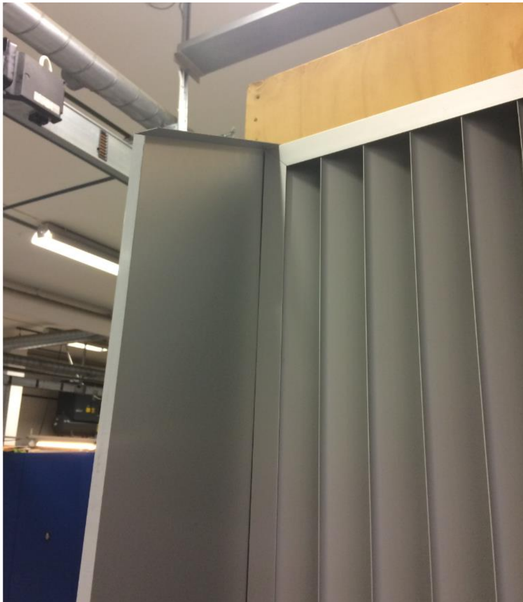
Kuva 1: Sivupellit kiinnitetään sääsuojaan. Peltipokkaus ylös/eteen
