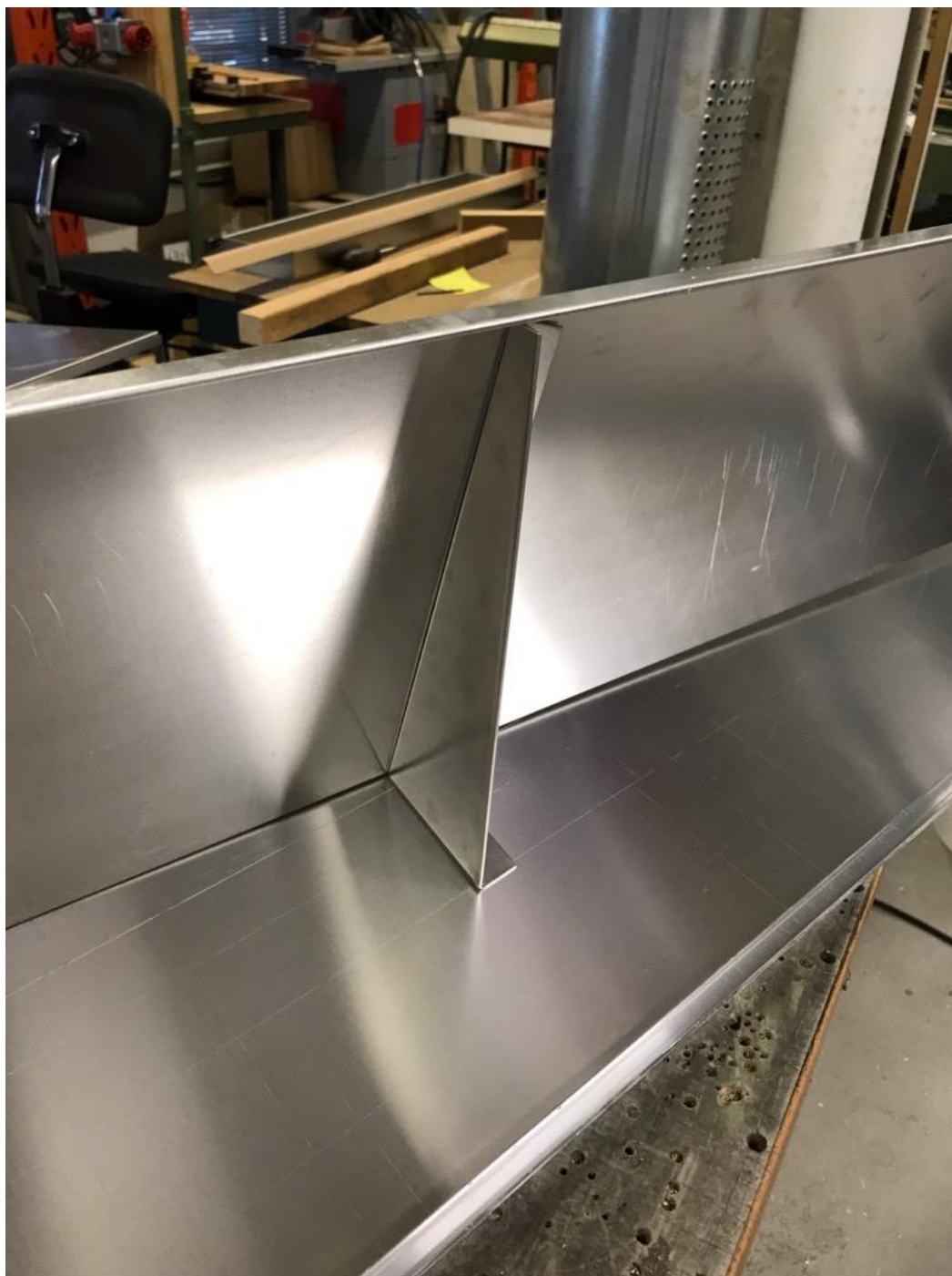
Kuva 1: Alapellin kannake (isompi) kiinnitetään seinään ja alapeltiin, keskelle alapeltiä (ruuveilla)
